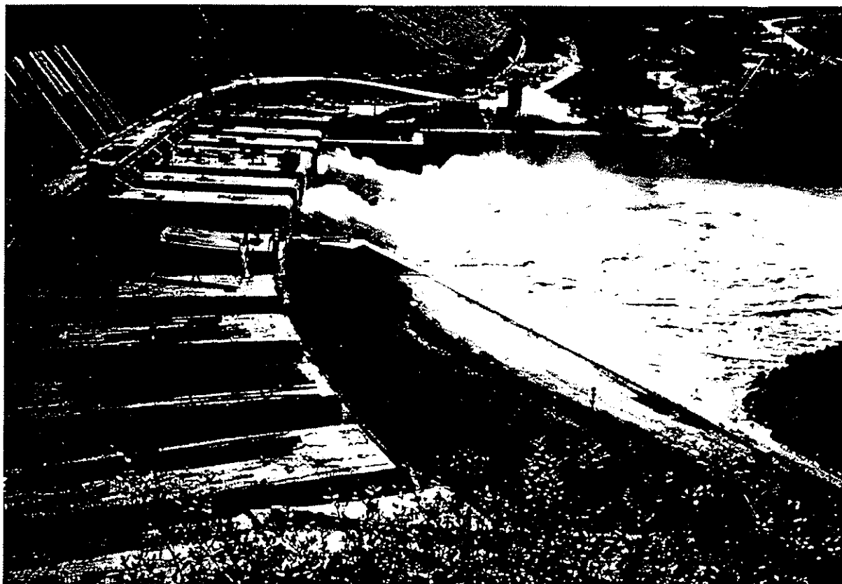
Fig. 22 Apertura degli scarichi della diga durante una piena del fiume Tevere avvenuta nel corso dell'esecuzione dei lavori
