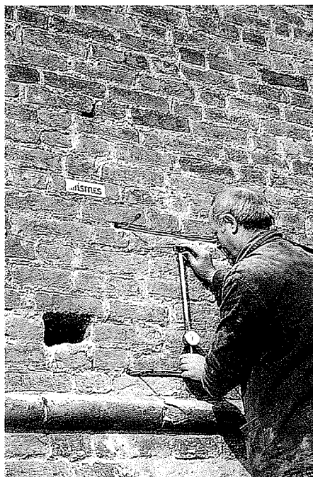
Fig. 7 Determinazione delle caratteristiche di deformabilità mediante prova con doppio martinetto piatto alla base del Campanile della Chiesa del Carmine
