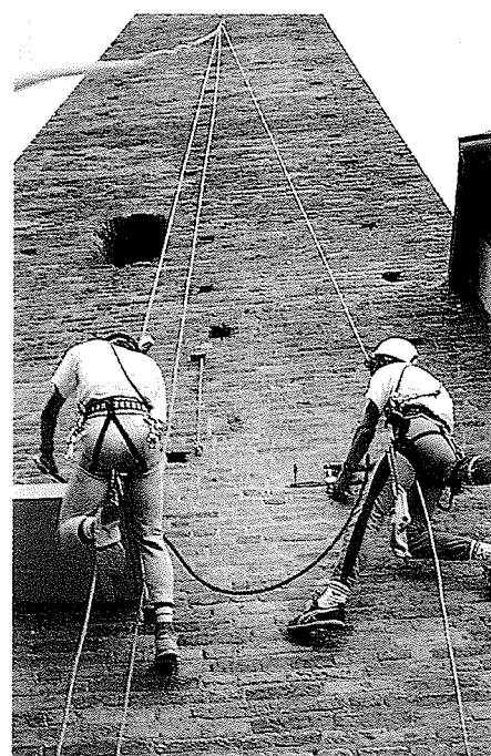
Fig. 6 Prova con martinetto piatto eseguita in parete con l'ausilio di esperti rocciatori per le misure delle sollecitazioni nel paramento esterno della Torre S. Dalmazio
