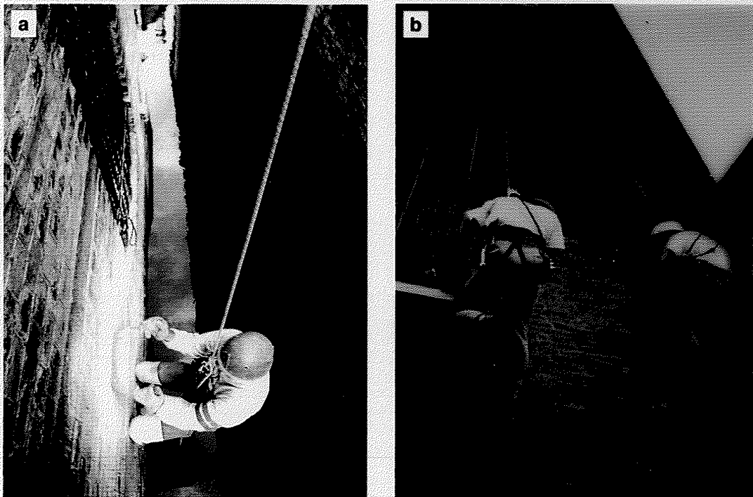
Fig. 15 - Esecuzione di prove con martinetto piatto su strutture alte senza l'ausilio di ponteggi metallici. a) Campanile di S. Stefano in Venezia b) Torre Fraccaro - Pavia.
