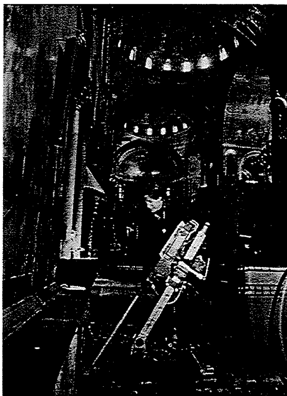
Fig. 5 - Carotaggio meccanico sulle strutture di fondazione di un pilastro
